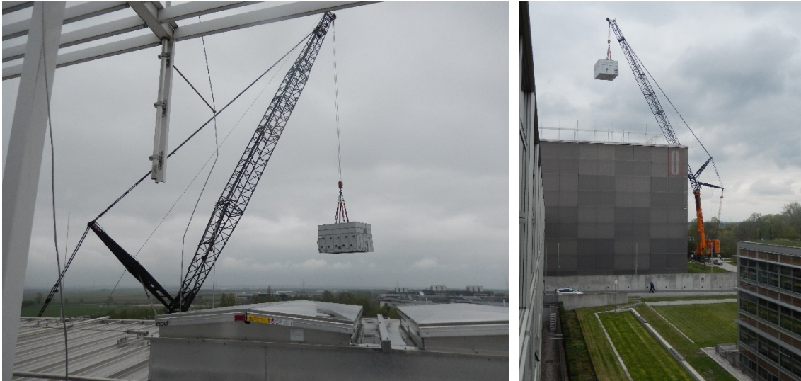
Abbildung 2: Arbeiten zur Stabilisierung der Rückkühlwerke auf dem Dach des Rechnergebäudes
